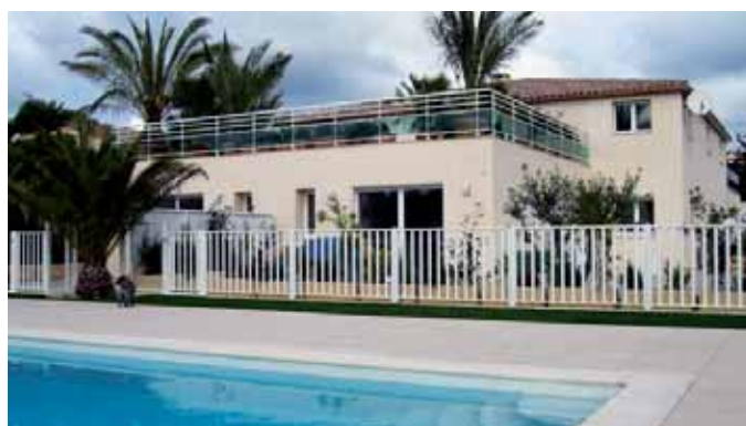
VILLA SUR TOIT MOUGINS 1 500 000 €
