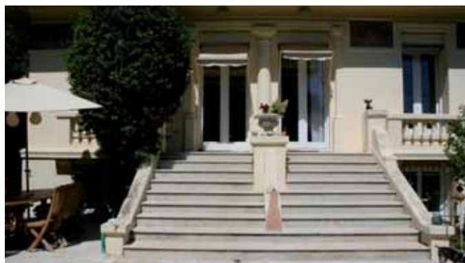
MAISON 5P CANNES / PROCHE CENTRE 1 277 000 €
